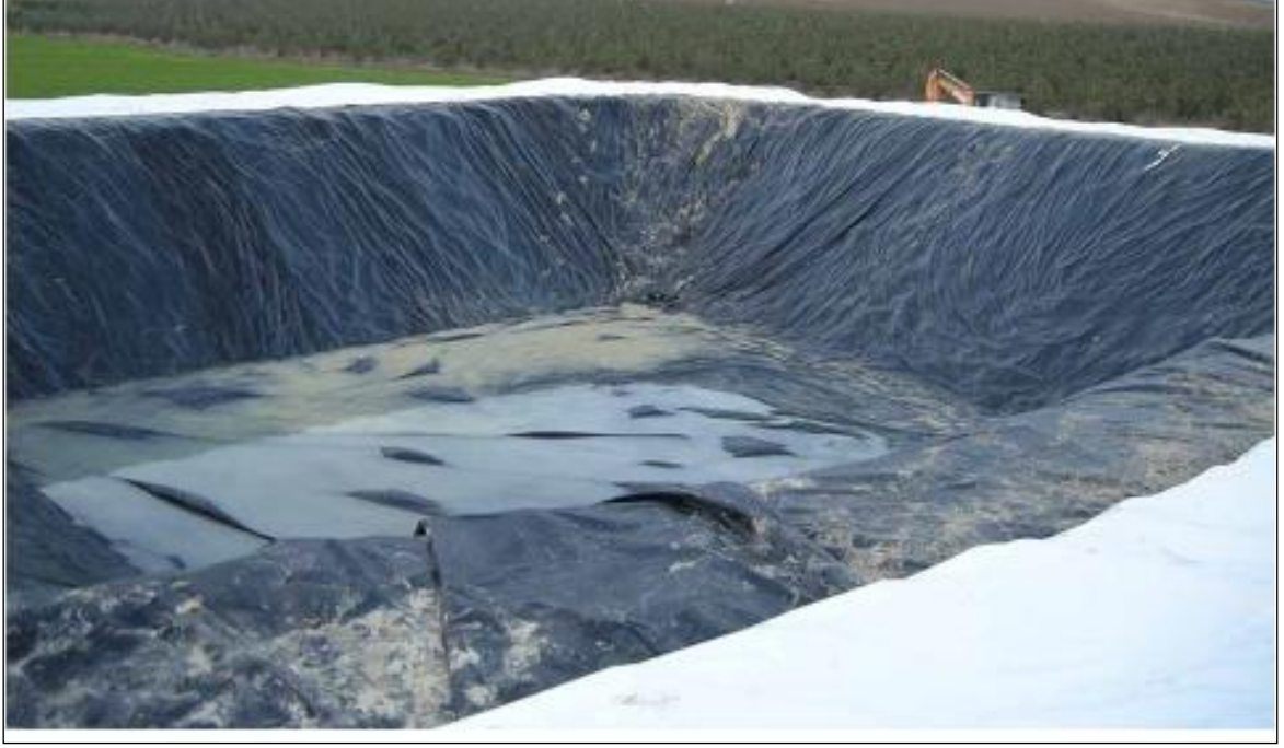
Şekil 3. Jeomembran Kapaklı Örnek Havuz Fotoğrafı
