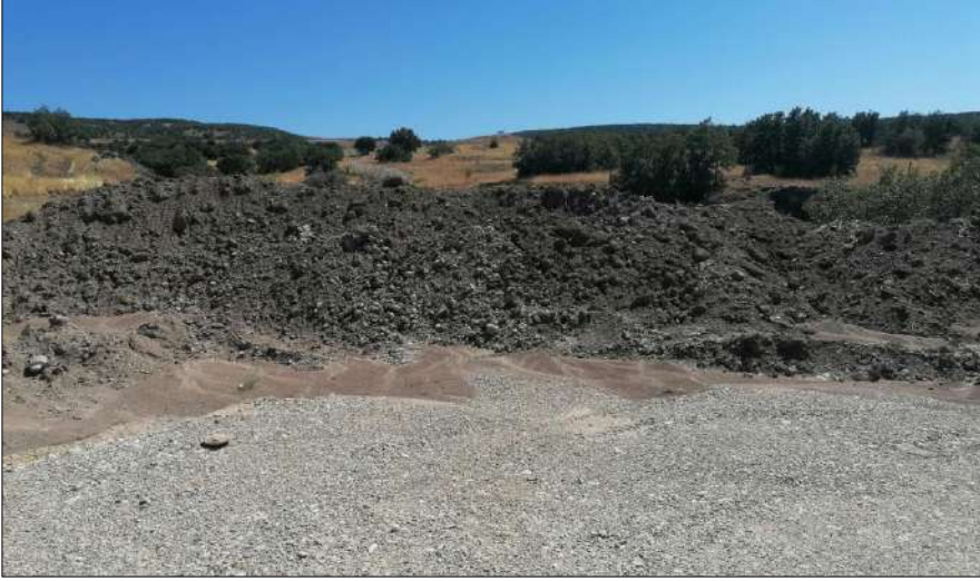
Şekil 4.6. Gaziemir-2 Lokasyonunda Depolanmış Olan Bitkisel Toprak
