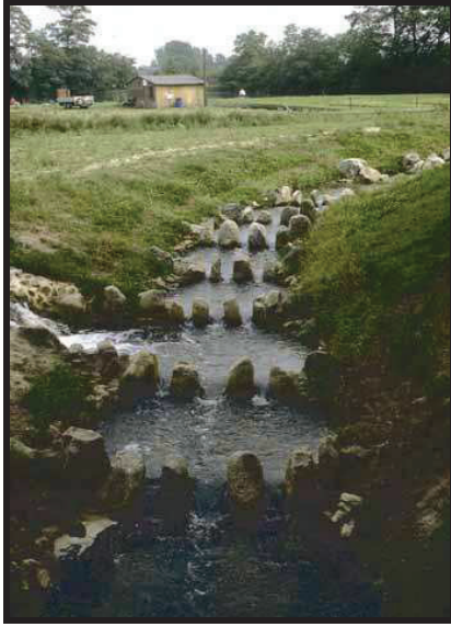
Şekil 4.2. Varrel Bake Deresi ve Stöbber Nehri Yan geçit kanalları (DSİ, 2009)
